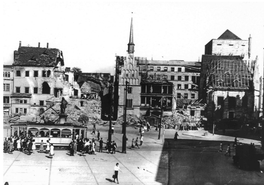
Dieses Foto zeigt Kriegsschäden am Alten Rathaus (rechts) und der Ratswaage (links) 1945. Hinter dem Alten Rathaus ist der Ratshof erkennbar. Foto: Sammlung W. Schönfeld, Halle (Saale)
